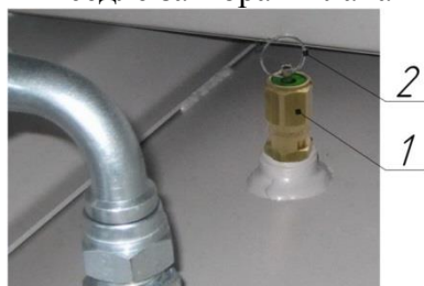
Рисунок 9 – Клапан предохранительный пружинного типа
